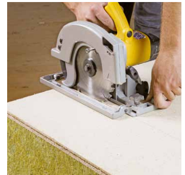
Einfaches Zuschneiden mit der Handkreissäge
