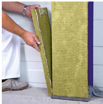
Pose du revêtement anti-feu sur les faces latérales
