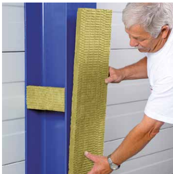
Pose du revêtement anti-feu contre l'aile
