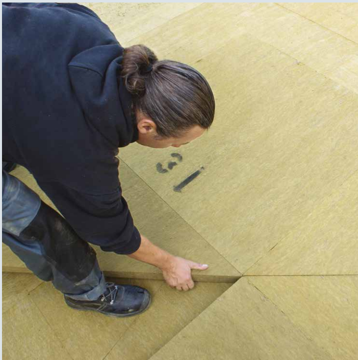
Gefälle-Dämmplatten von unterschiedlicher Stärke lassen sich zu einer homogenen Dachneigung kombinieren. Jede Platte ist deutlich beschriftet.
