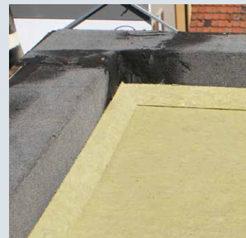
Der Dachkeil sorgt für einen einwandfreien Abschluss ohne Wasserstau.
