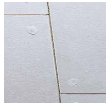
Montage mit Spezialdübel.
